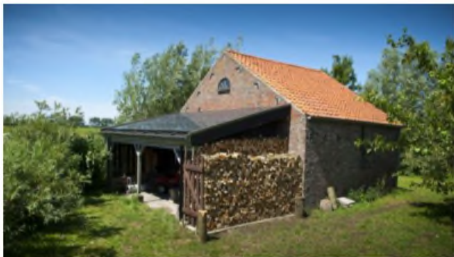
Op een aanbouw (voldak)
