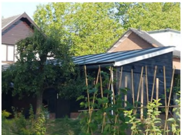
Op bijgebouw syteem met uiterlijk zinken dak
